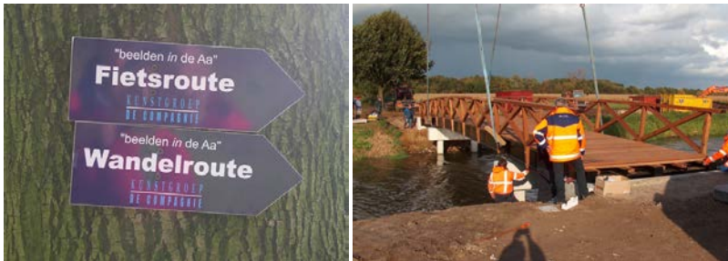
Plaatsing van een fietsbrug over de Aa in Veghel, oktober 2008.
