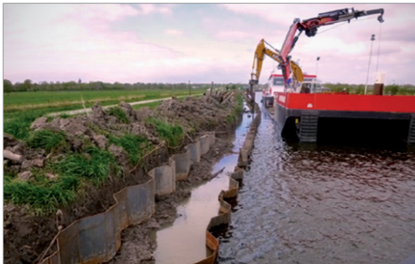
Vervanging van de beschoeiing van De Eem.
